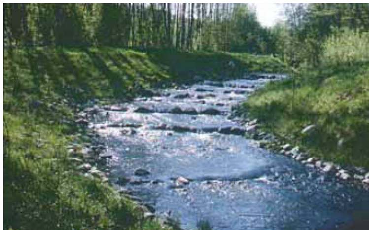
Figura 4.2.6 Esempio di un canale by-pass per l'ittiofauna realizzato.
